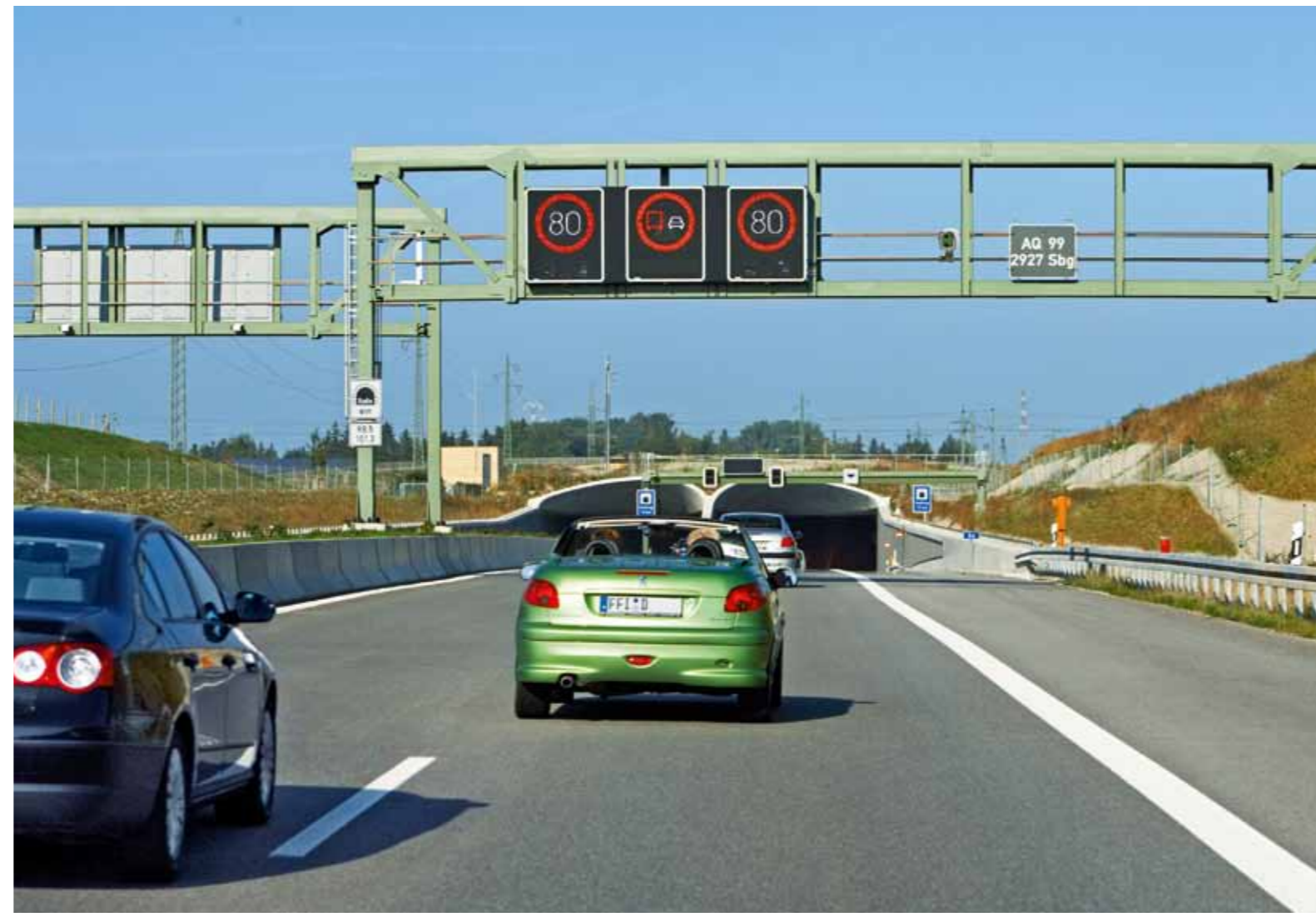
Sicore, trafik kontrol cihazlarını destekleyen tabela köprülerine kolayca entegre edilebilir.
