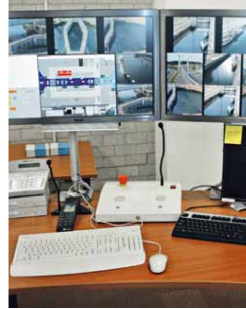
Sayıları 23'ü bulan kamera, kanallardaki mevcut duruma ilişkin görüntü malzemesini sürekli olarak kontrol istasyonunun ekranına gönderir.
